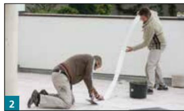
2 Die Drainagebahn wird nach Herstellerangaben aufgebracht. Bei der Festverlegung wird M21 HP Speed mit einem 6 x 6 mm Zahnpachtel aufgekämmt und anschließend die Drainagebahn mit einem Glätter ins Kleberbett durch Andrücken eingebettet.
