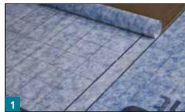
1 Nach Aufrollen und Trocknen der Grundierung D11 klebt man die AE-Bahn mit M21 HP Speed unter Verwendung eines 4 – 6 mm Zahnpachtels auf. Die Stöße sind in Fließrichtung zu überlappen.
