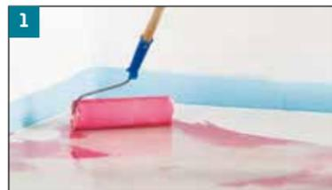
1 Die Grundierung von saugfähigen Bodenflächen erfolgt mit D11. Alternativ kann D11 mit dem Pinsel aufgetragen werden.
