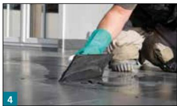
4 Mit einem Epoxidharzfugbrett kann Multifuge Diamond Max leicht eingefugt werden.
