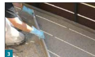
3 Nach Stellung eines Randdämmstreifens kann der Drainagemörtel mit einer Mindeststärke von 2 cm aufgebracht, abgezogen und geglättet werden.
