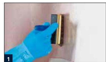
1 Grundierung des Betons mit der einkomponentigen Grundierung D11. Vor der Grundierung ist der Beton auf Sinterschichten und Schalölreste zu prüfen.
