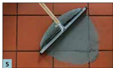
5 Verfugung der Platten mit MULTIFUGE Base oder MULTIFUGE Fine Speed.
