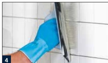
4 Boden mit Multifuge Base, Multifuge Fine Speed Wand mit Multifuge Fine
