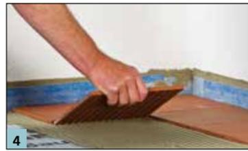
4 Verlegen der Platten mit M21 HP / M21 HP Speed im kombinierten Verfahren.
