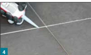
4 Der Fugenverschluss erfolgt mit S5 Supax
