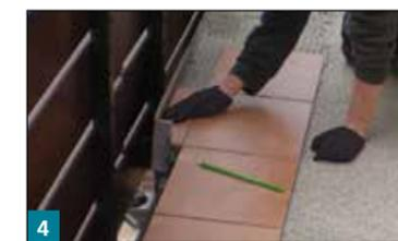
4 Der Kleber BTK200 Terrachamp wird auf den Drainagemörtel mit dem für die Formatgröße passenden Zahnglätter aufgetragen.
