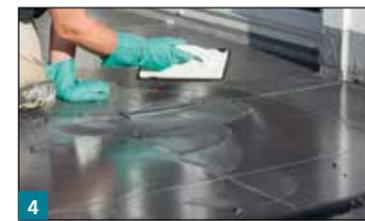
4 Mit einem Epoxidharzfügebrett kann Multifuge Diamond Max leicht eingefügt werden. Verarbeitungs- und Untergrundtemperatur +10 °C bis +25 °C.
