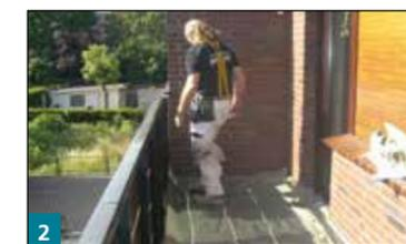
2 Auf einer Abdichtung wird eine 1-lagige PE-Folie auf einem Untergrund mit mindestens 1,5 – 2% Gefälle aufgebracht und im Randbereich an angrenzenden Bauteilen hinaufgeführt.
