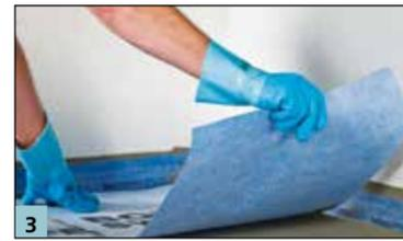
3 Einlegen der AE Abdichtungs- und Entkopplungsbahn in M21 HP / M21 HP Speed mit 5 cm Überlappung.
