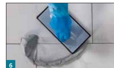
6 Verfugung des großformatigen Belages mit MULTIFUGE Base, MULTIFUGE Fine, MULTIFUGE Fine Speed oder MULTIFUGE Diamond Max
