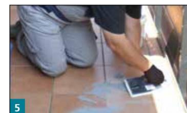
5 Auf dem getrockneten Belag wird der Reaktionsharz-Fugenmörtel 3K Diamond Max mit einem Fuggummi eingefugt und abgewaschen.
