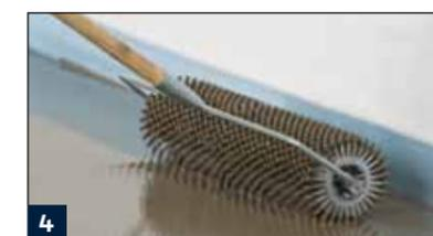
4 Entlüftung der Ausgleichsschicht mit einer Stachelwalze.
