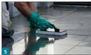
5 Nach dem Anziehen der Fuge wird diese mit einem Schwamm Brett in Form gebracht und das überschüssige Material abgewaschen.
