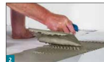
2 Kunstharzgebundenen Platten: Aufziehen des Epoxidharz-Fugen- und Klebemörtel EKF500 oder MULTISTONE in Fließbettkonsistenz mit einem ausreichend großen Zahnglätter. Bei großformatigen Platten: MULTISTAR in Fließbettkonsistenz mit einem ausreichend großen Zahnglätter
