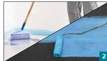
2 Grundierung alter festhaftender Beschichtungen mit D1 Speed. Grundierung eines alten, unbesandeten Gussasphalts.
