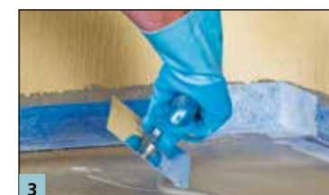
3 Einarbeitung von SB78 Dichtband und Innenecke in MD1 Speed oder Multiproof.
