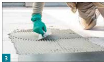
3 Der BTK 200 Terrachamp wird mit einem Zahnpachtel passend zur Formatgröße des Belags aufgekämmt. Das kombinierte Verfahren und damit eine hohlräumfreie Verlegung ist nicht erforderlich!
