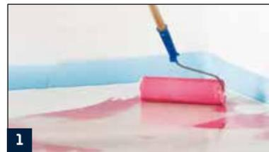
1 Die Grundierung von saugfähigen Bodenflächen erfolgt mit D11.
