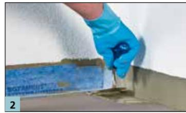
2 Einarbeitung von SB78 Dichtband und Innenecke in M 21 HP / M 21 HP Speed.
